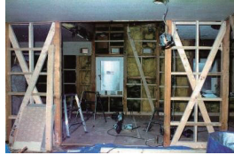
筋交いの設置
