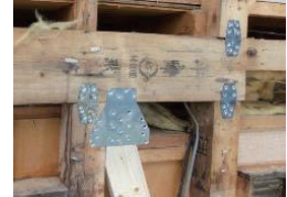
補強金物の設置
