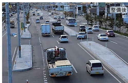
整備後幅員（50.0m）
