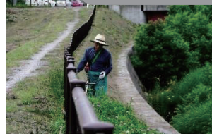
堤防の草刈り
