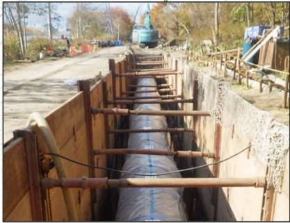
工事施工状況
