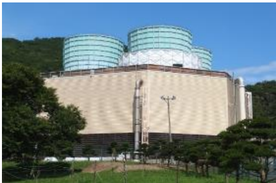
北海道電力(株) 森地熱発電所
