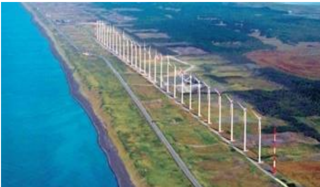
オトンレイ風力発電所、幌延風力発電(株) (出典：NEDO)
