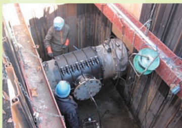
不断水工法により分岐作業の様子
