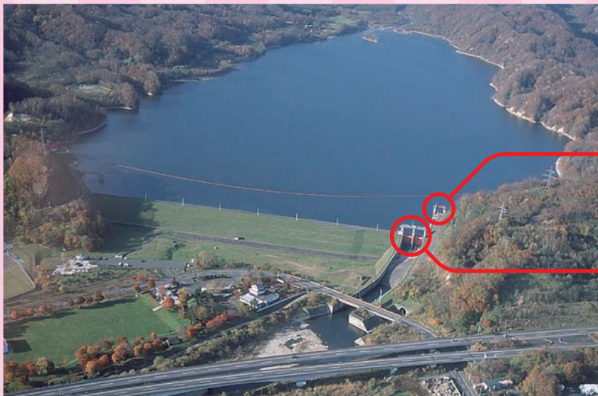
幌別ダム全景
