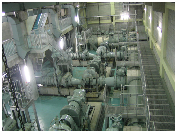
鷺別ポンプ場
