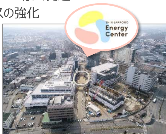
省エネと災害に強い街づくりを支える 新さっぽろエネルギーセンター
