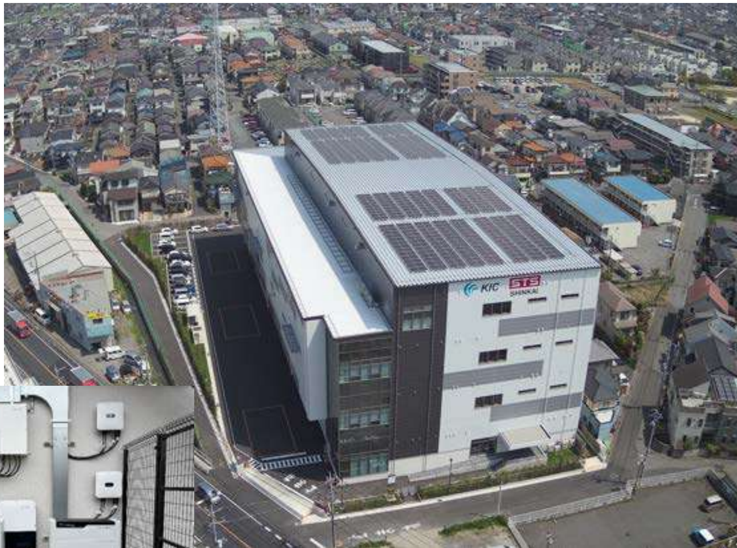
KIC 越谷ディストリビューションセンター 太陽光発電180kW & 蓄電システム (BCP対策)
