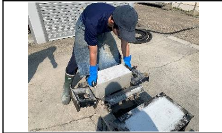
工業科：フェンスブロックの製造
