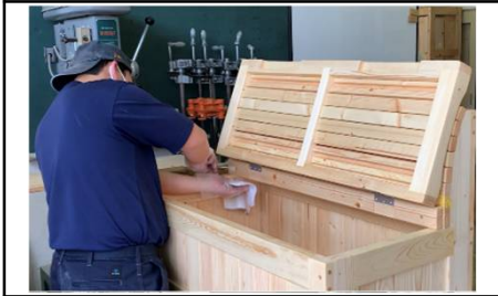
木工科：仕上げ塗装
