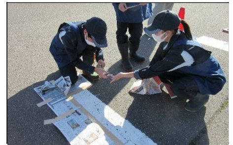
特設実習：駐車場のライン引き
