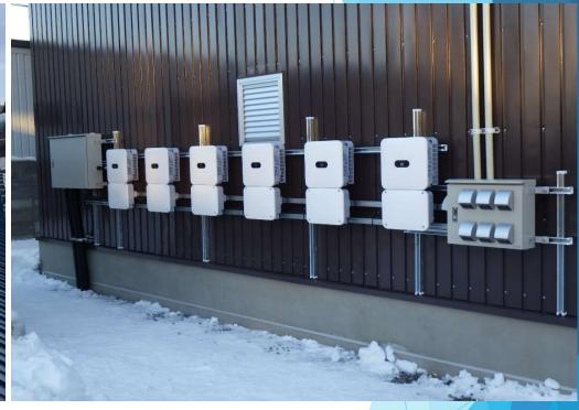
令和4年度 北海道 製造業省エネルギー環境整備緊急対策補助金対象 屋根上ソーラパネル50KW パワーコンディショナー 30kW
