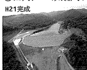
⑦西岡ダム(剣淵町) H21完成
