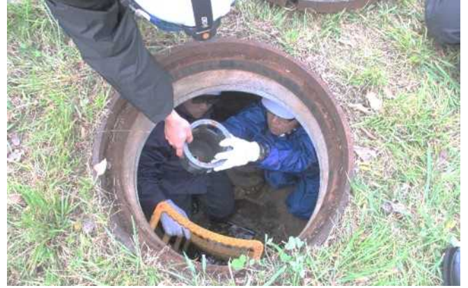
【配水管ルート及び充断水作業研修】
