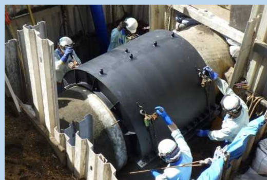
【H30胆振東部地震 漏水復旧作業】
