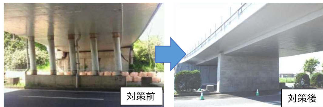
橋梁の耐震化の事例
