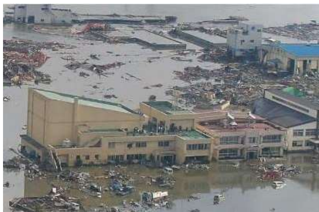
津波による被害
