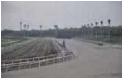
外走路改修 (H28)
