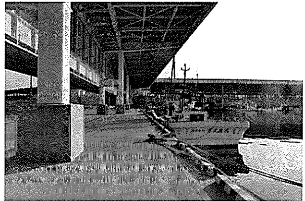
【屋根付き岸壁を整備した漁港（常呂漁港）】
