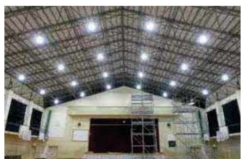
中学校体育館へのLED照明導入
