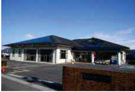
市民共同発電所 4号機
