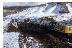
用水路の復旧工事に着手(厚真町)
