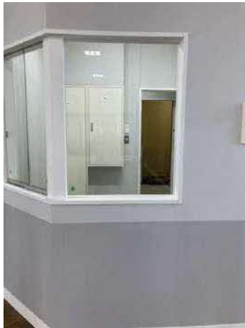
整理員室 場内が一望できる窓を 設置し監視が容易に
