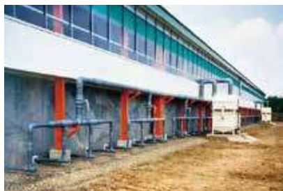
▲大規模海産物加工残渣発酵施設
