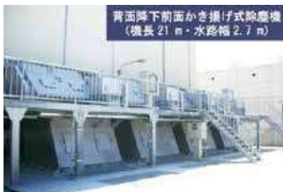
▲関東地方で納品した かき揚げ式除塵機 (機長 21 m・水路幅 2.7 m)
