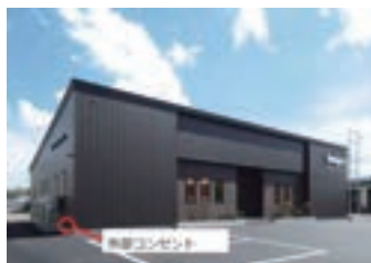
EV導入を見据え、社屋に外部コンセントを設置<宣誓項目>
