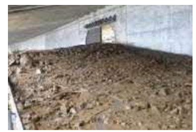
▲ 平成28年大雨等災害による覆道内への土砂流入(道道108号(利尻富士町))
