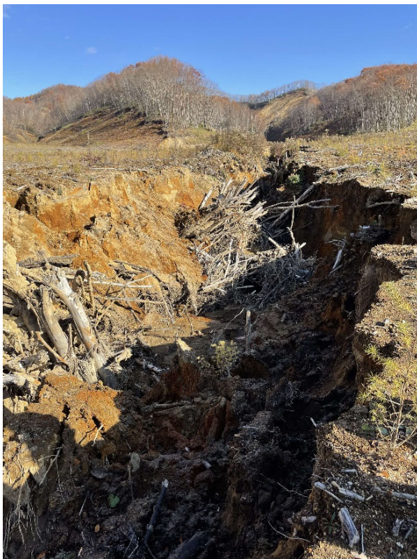
大規模に洗堀された現場
