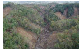
地震による被害地
