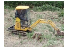
機械による下草刈り作業
