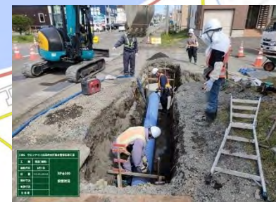
雨水管渠布設工事 (稚内市)
