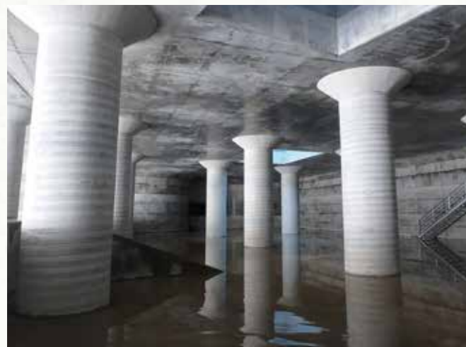
▲2つの川を地下でつなぐ放水路トンネルの一部の様子
