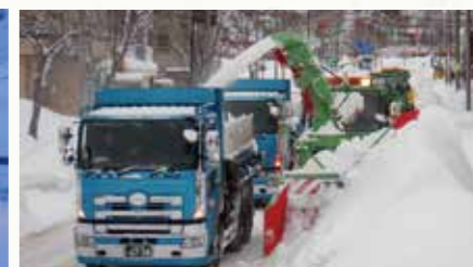
▲運搬除雪状況
