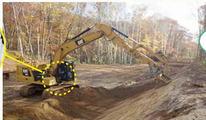
▲〔施工〕3Dマシンコントロールバックホウ
