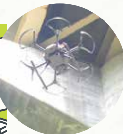
▲ドローンによる橋の点検状況
