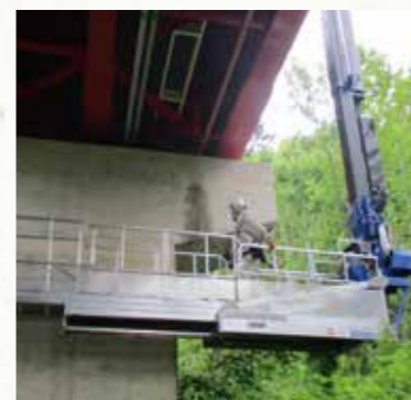
▲目視による橋梁の定期点検の実施状況
